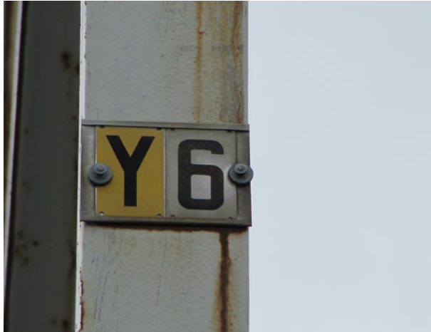
Kuva 4. Numerokylttiin kiinnitetty pylväsnumero
