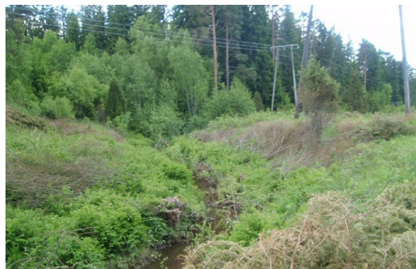
Kuva 11. Oja puhdistettu kaadetuista puista
