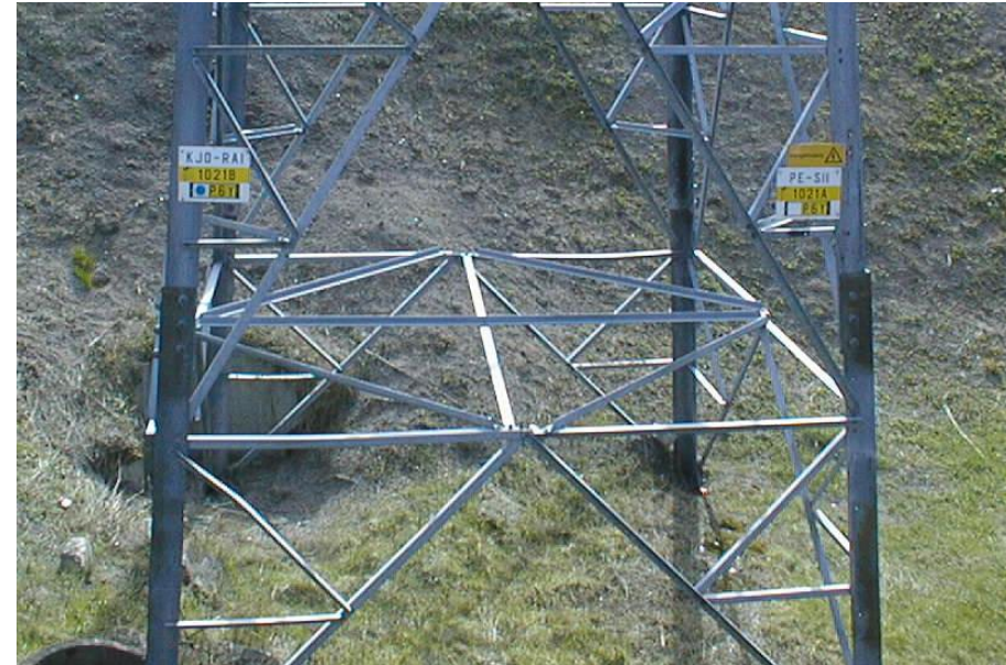
Kuva 7. Pylvästunnistekilvet kahden virtapiirin pylväällä
