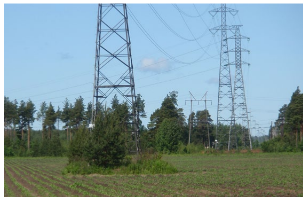
Kuva 12. Pylväsalan raivaustarve peltoalueella
