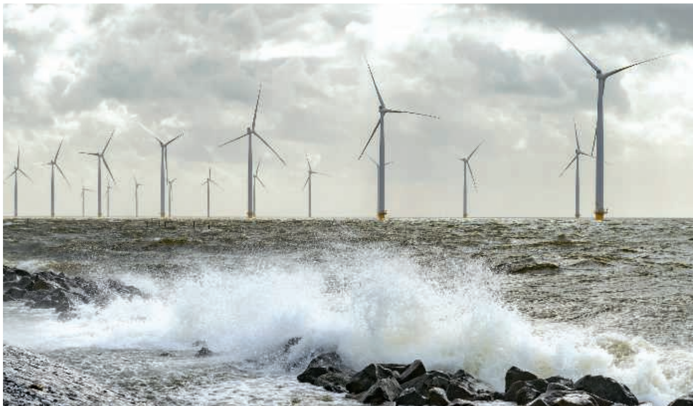
Tuulivoimalat pysäytetään kovien myrskyjen aikana, kun tuulennopeus nousee pidemmäksi aikaa 25–30 metriin sekunnissa. Suomessa tällaisia myrskyjä on harvoin.
