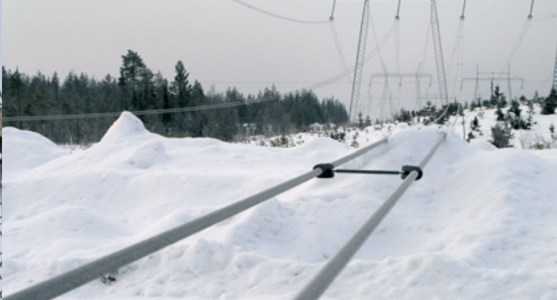
Virtajohtimia (3 x 2 Finch) ei uusittu. Ainoastaan kuluneet tai vaurioituneet johdinvarusteet vaihdettiin.
