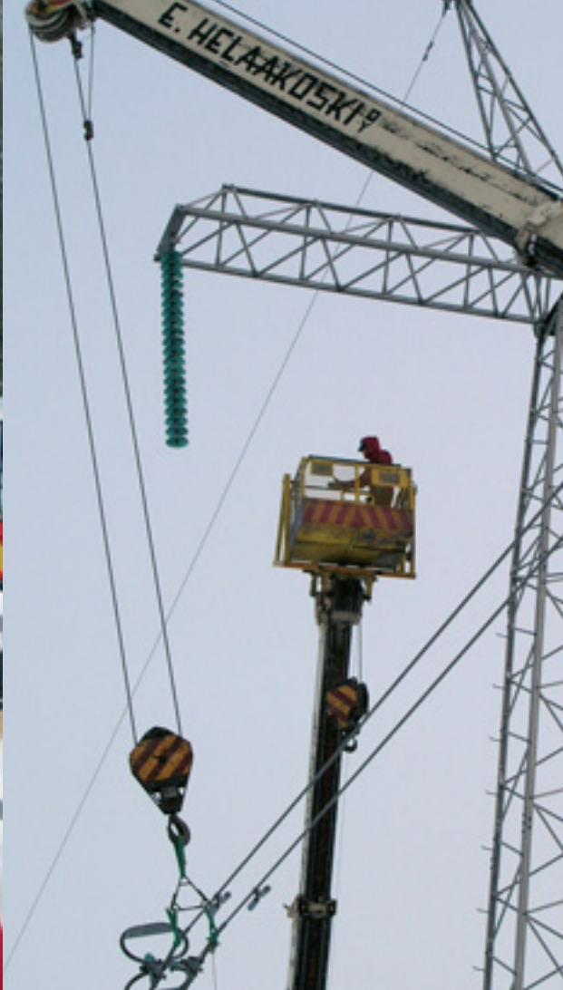
Virtajohtimia (3 x 2 Finch) ei uusittu. Ainoastaan kuluneet tai vaurioituneet johdinvarusteet vaihdettiin.
